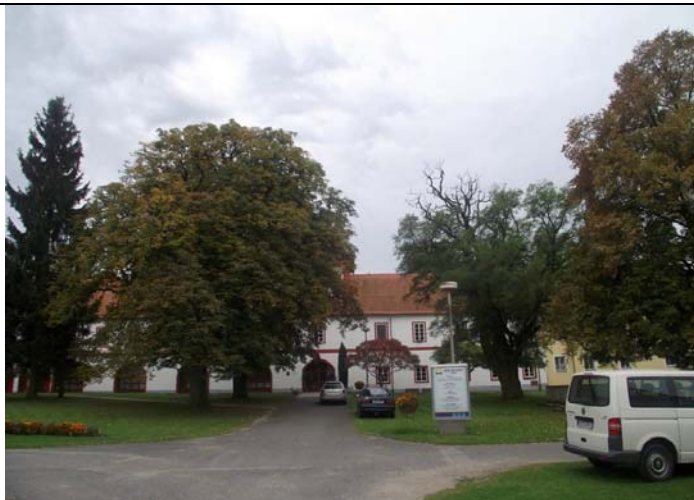
Severní průčelí zámku se skupinou neošetřených stromů a nebezpečným smrkem vlevo v rohu zámku.
