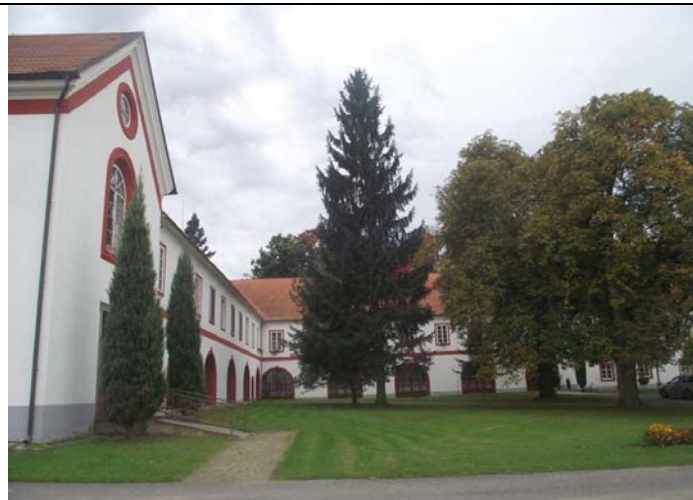
Pohled na totéž místo od úrovně zámecké kaple se vstupem lemovaným dvěma jalovci skalními.
